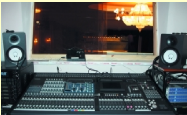
Специалисты «Системы» использовали в проекте универсальную цифровую микшерную консоль YAMAHA PM5D
